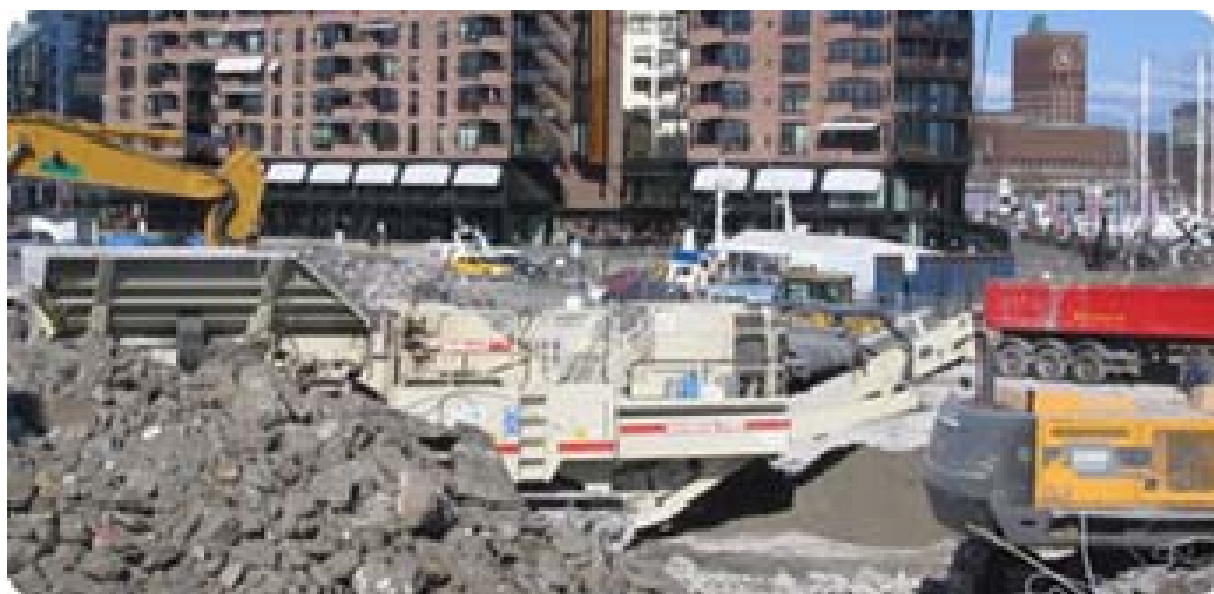
Figur 40. Knusing av betong på Tjuvholmen ved Aker Brygge i Oslo
