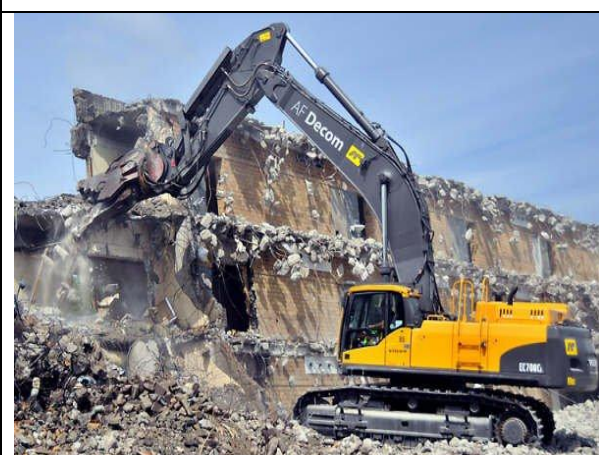
Figur 27. Gravemaskin med betongknuser
