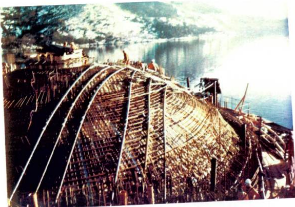
Figur 8. Armering øvre kuleskall
