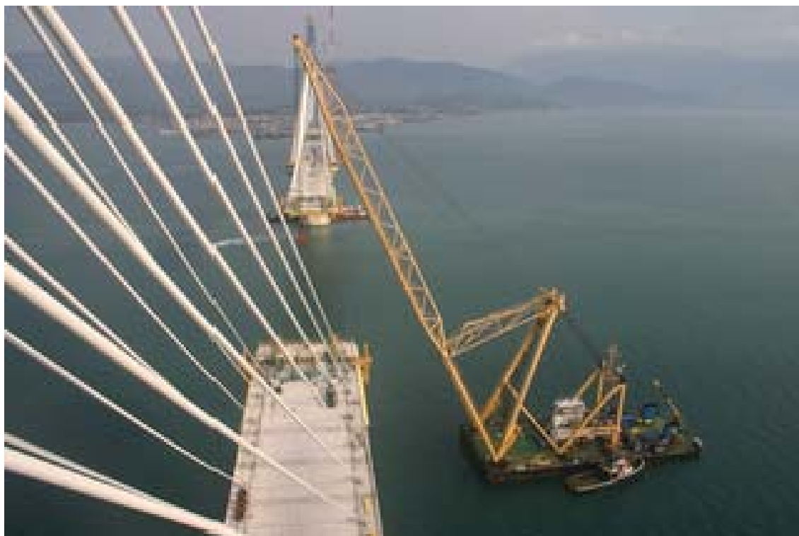
Figur 24. Shearleg Taklift 7
