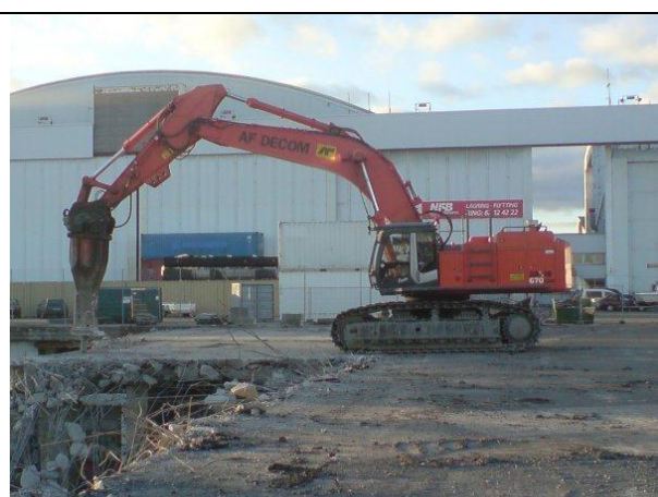
Figur 26. Gravemaskin med hammer
