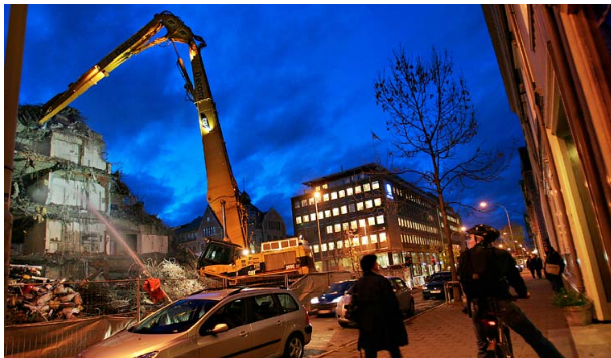
Figur 29. Rekkevidde 33meter med verktøy på omkring 5 tonn. Totalvekt omkring 100 tonn.
