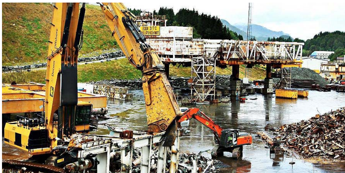
Figur 30. Rekkevidde 33m med verktøy på 20 tonn. Totalvekt omkring 320 tonn.
