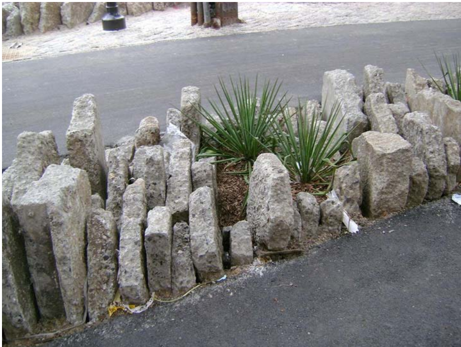
Figur 13. På Queensboro Plaza i New York har man brukt betongbiter til å lage trafikkøyer og skille forskjellige trafikanter. Kilde: http://inhabitat.com/nyc/jagged-chunks-of-sidewalk-reused-to-create-unique-median-for-queens-plaza/comment-page-1/
