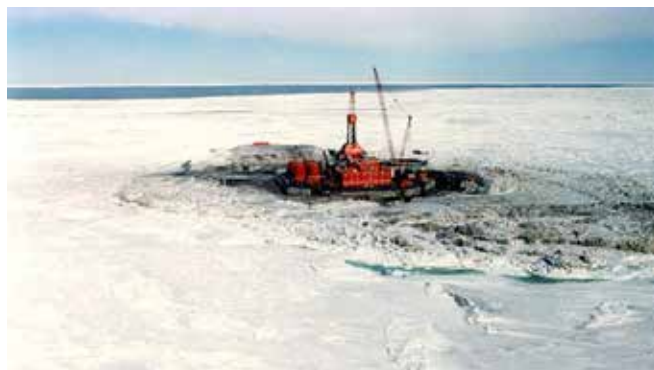
Figur 16. Leteboring i Beauforthavet fra konstruert øy i 1982 (venstre), og vinteren (høyre) (AlbertaOilMagazine, 2015).
