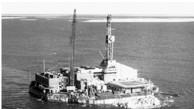
Figur 16. Leteboring i Beauforthavet fra konstruert øy i 1982 (venstre), og vinteren (høyre) (AlbertaOilMagazine, 2015).
