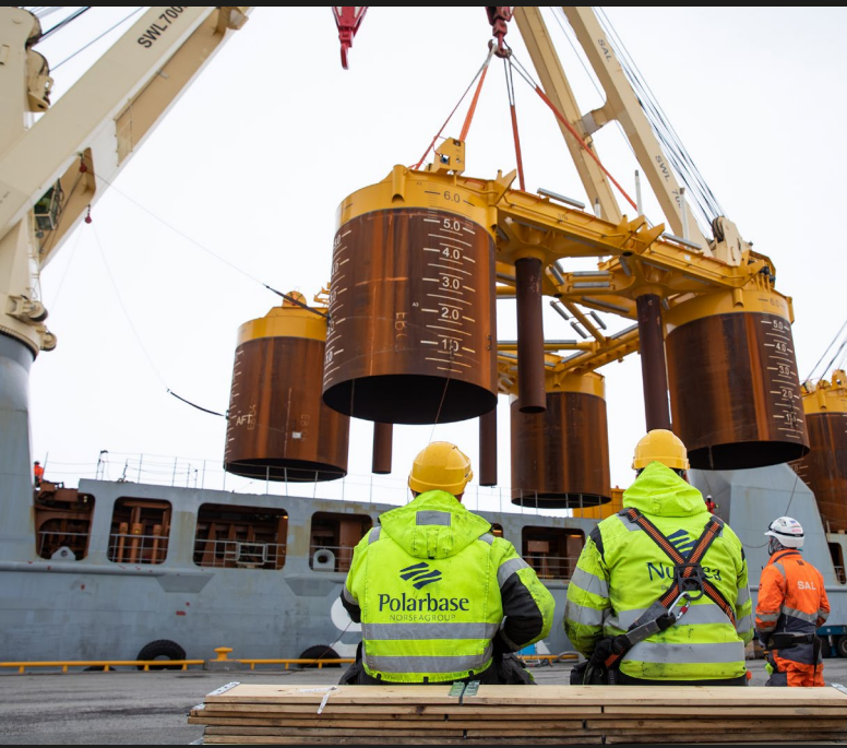
Foto: Gravås/Kleppa, Equinor
