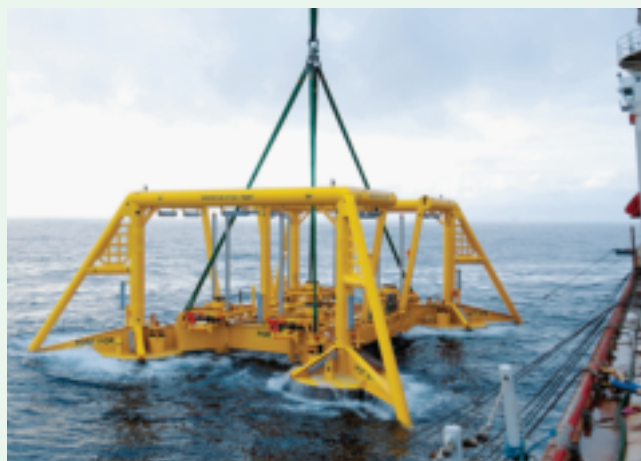
Figur 2.9 Installasjon av en bunnramme på Vigdis. Foto: Equinor
