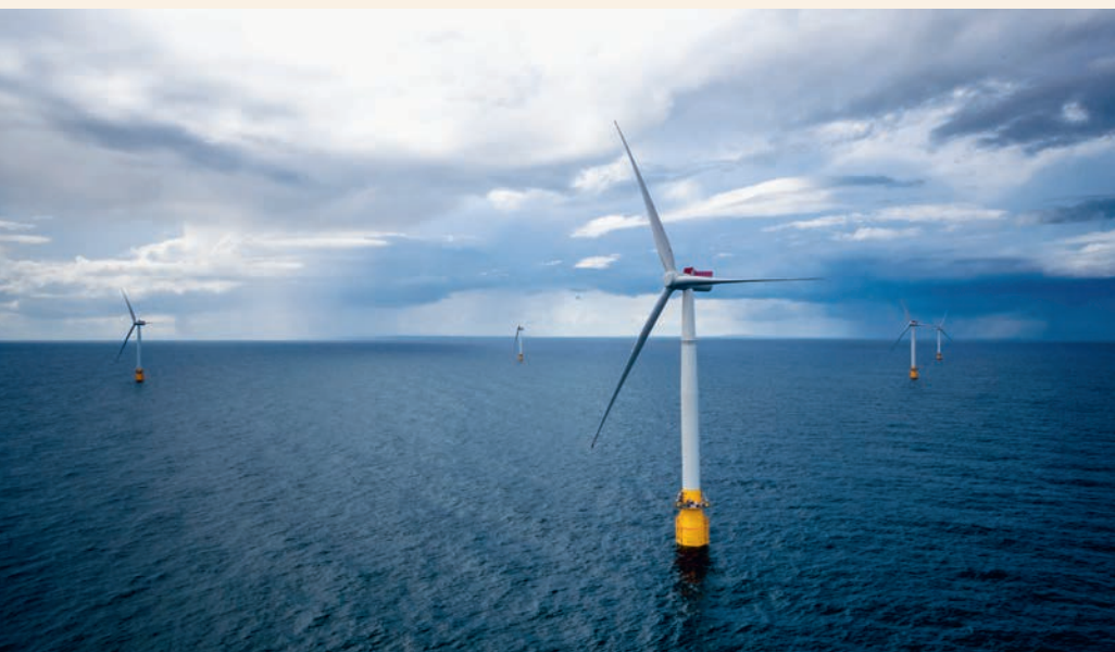
Figur 3.5 Havvindturbiner. (Foto: Øyvind Gravås - Woldcam, Equinor)
