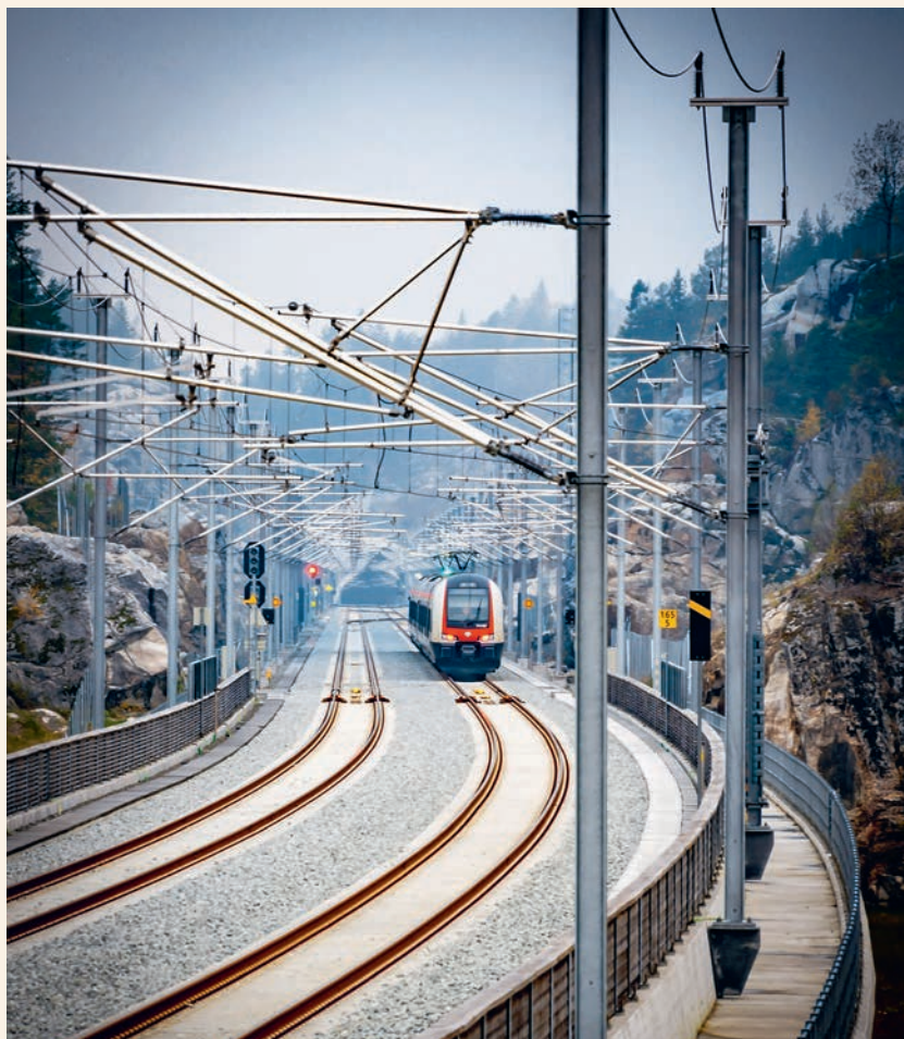
Figur 3.4 Elektrisk tog. (Foto: Bane NOR)
