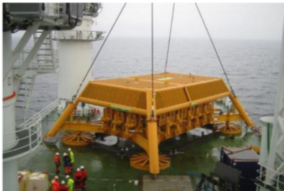
> Figur 10-11: Installering av Yme manifoldstruktur [83]
