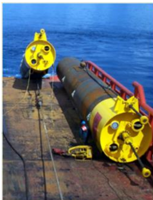
> Figur 10-7: Installasjon av sugeankre [79]
