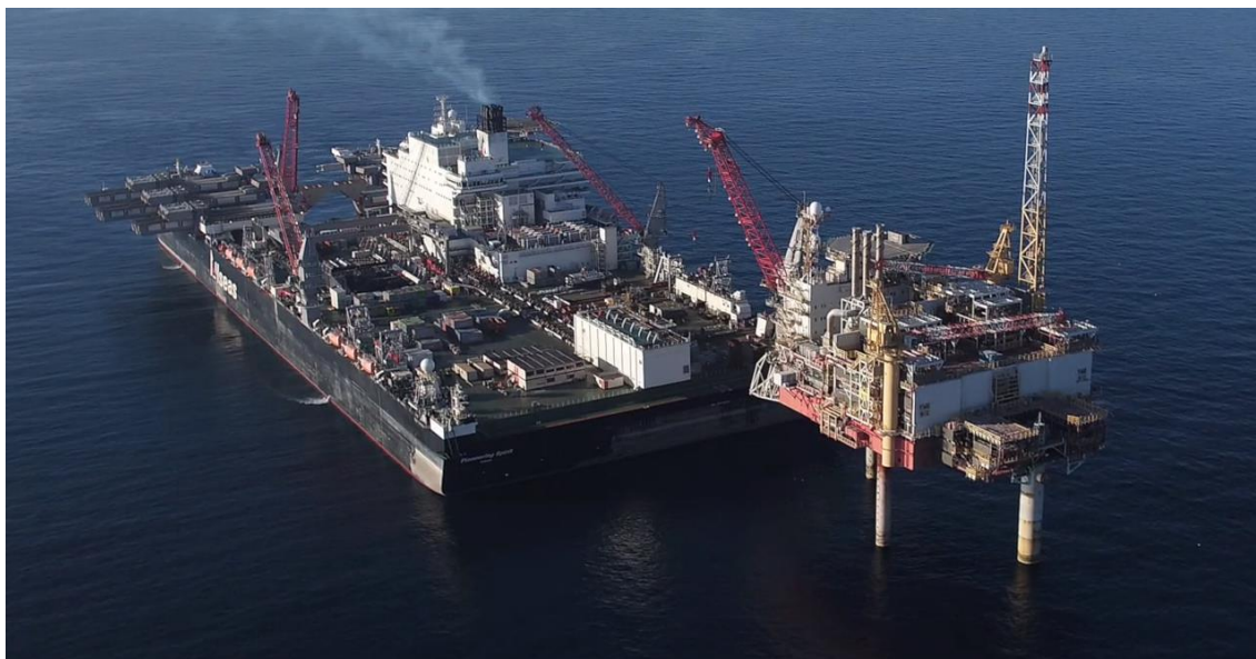
> Figur 7-17: Ankomst av Pioneering Spirit. Maskiner for kutting av søylene løftes om bord på dekkсанlegget.
