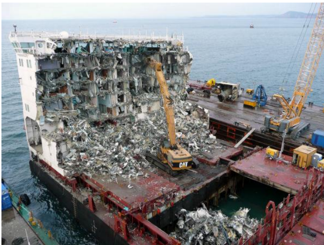
> Figur 7-3: Eksempel på fjerning av dekkсанlegg med bit-for-bit-metoden [27]
