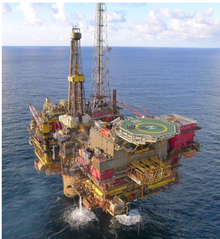
> Figur 7-14: Dekksanlegget på Brent Delta
