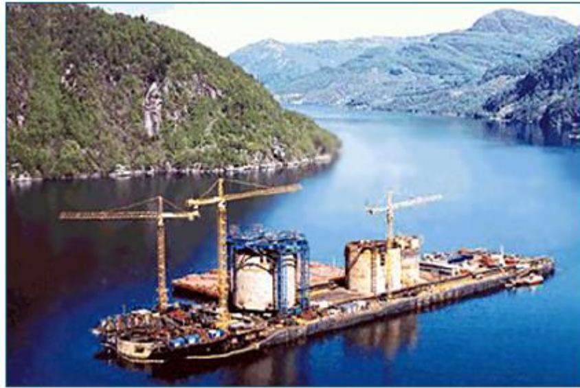
> Figur 9-7: Brent Spar på dypvannskai omkranset av lektere og kraner.
