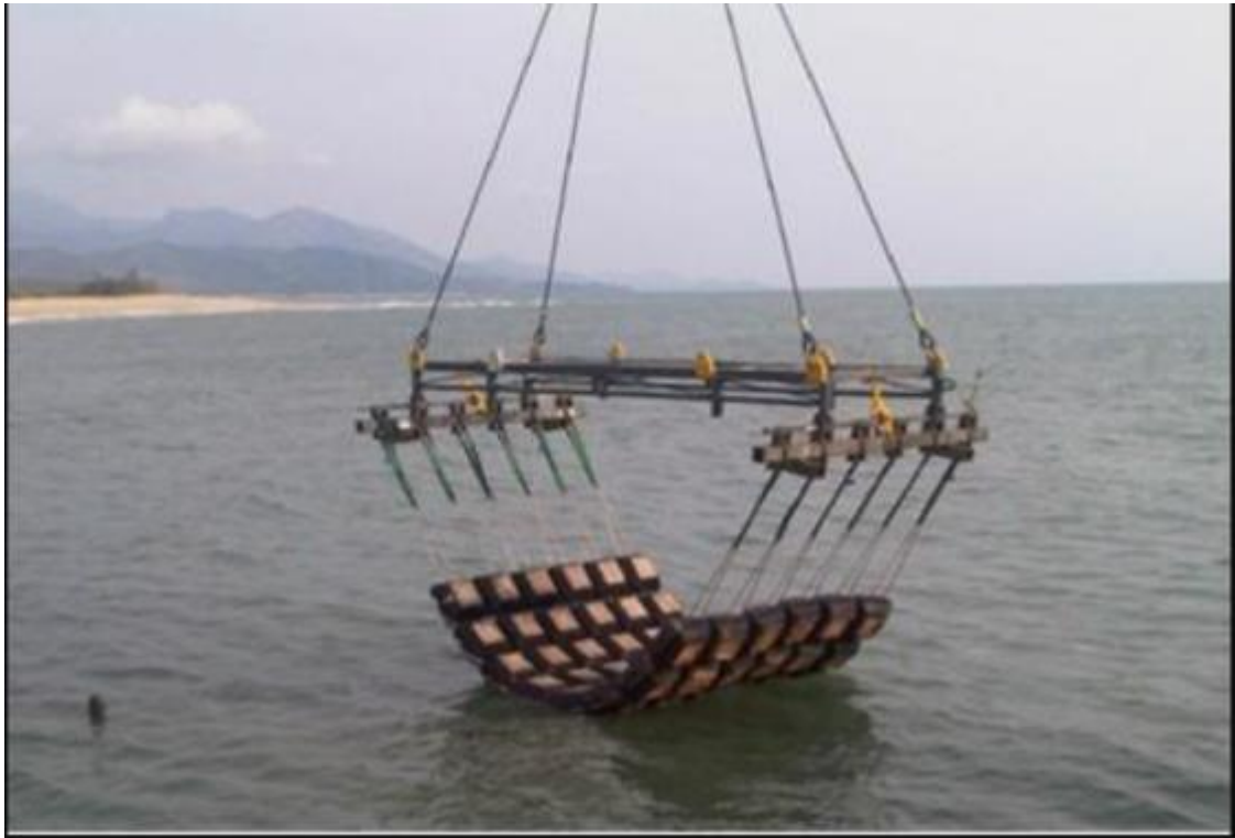
> Figur 10-5: Installasjon av betongmatte [77]
