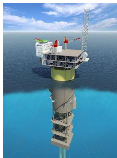
> Figur 9-1: Eksempel på semi-sub (Kristin) [62] og Sparbøye (Aasta Hansteen) [63]
